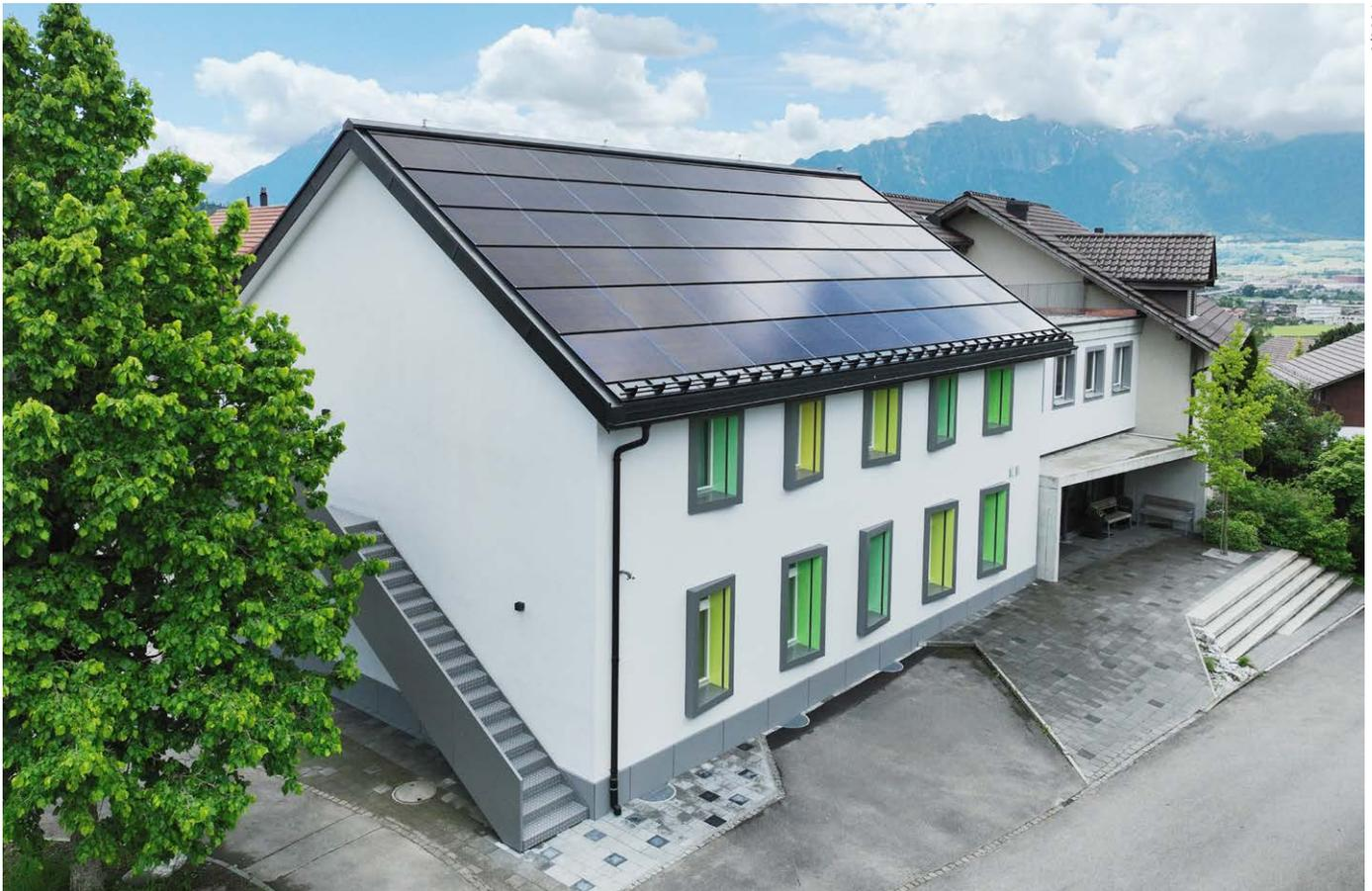
Das Versammlungsgebäude des EGW Steffisburg wurde äusserlich komplett saniert. Die Sanierung beinhaltet eine zeitgemässe Dämmung der Fassade, den Ersatz der bestehenden Spindeltreppe sowie die Installation einer Photovoltaikanlage.
