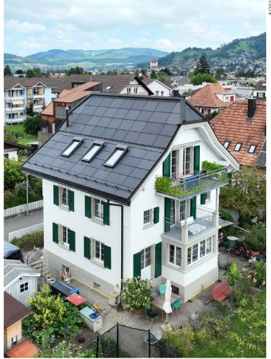
Bei diesem Einfamilienhaus wurden eine umfassende Sanierung und eine Aufstockung durchgeführt. Dabei blieb die bestehende Mauerwerkskonstruktion unter Beibehaltung der alten Dachform erhalten.
